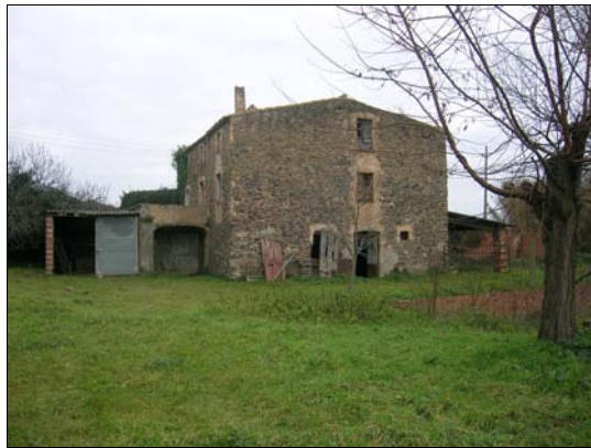
Façana Sud (principal)
