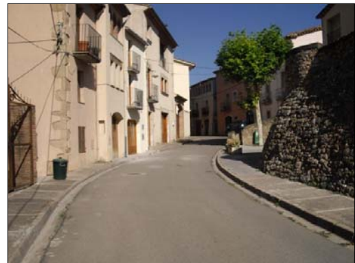
Carrer Girona, voreres en bon estat i còmodes, excepte alguns trams concrets.
