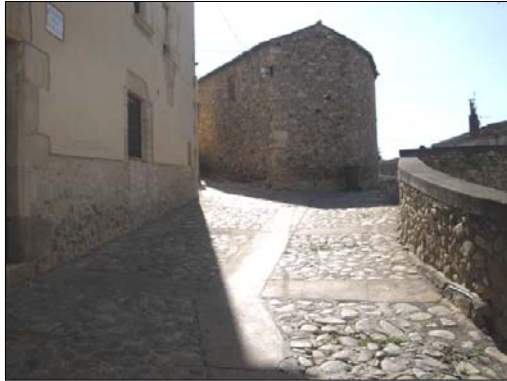
Carrer Muralla, empedrat i sense voreres.
