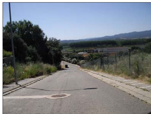
Carrer de la urbanització Castell, amb voreres estretes i amb obstacles (faroles).
