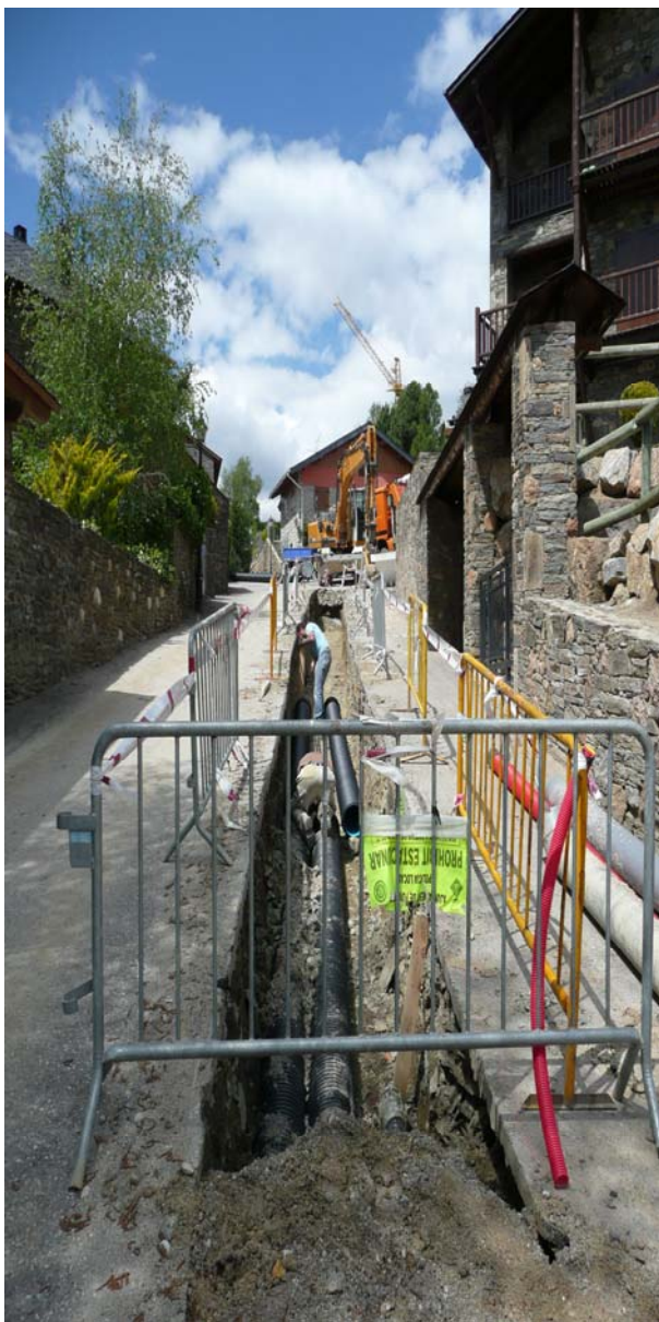
Obres al carrer Urgell
